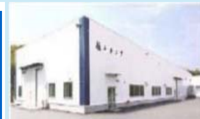
被災した工場・施設等の 復旧支援
