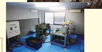
大阪府交野市にある地域活性化センターの浴場を改修し、製造工程を集約
